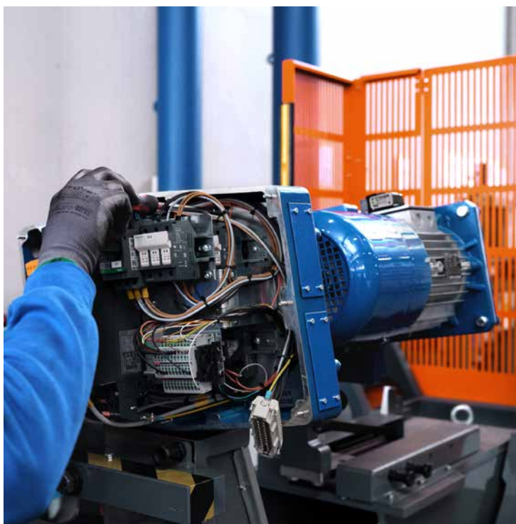
Electrical panel assembly / Assemblaggio quadro elettrico
